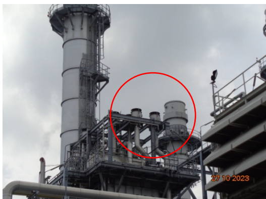
รูปที่ 7 Silencer บริเวณวาล์วท่อระบายน้ำ
