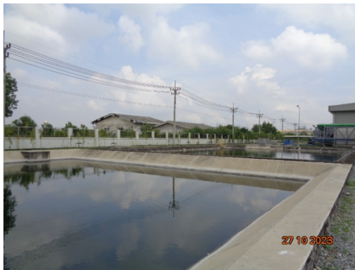
รูปที่ 11 บ่อพักน้ำทิ้งขนาด 800 ลูกบาศก์เมตร
