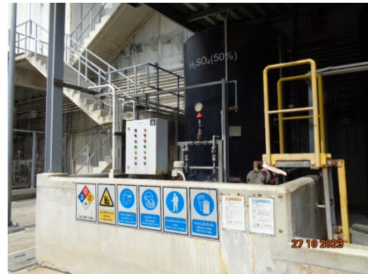
รูปที่ 55 กังแพงคอนกรีตล้อมรอบถังน้ำมันและสารเคมี
