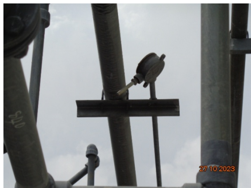
รูปที่ 33 Heat Detector
