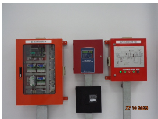
รูปที่ 29 Gas Detector System
